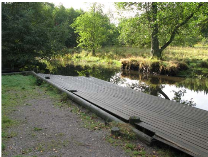
Befintlig brygga mot Skebokvarnsån
