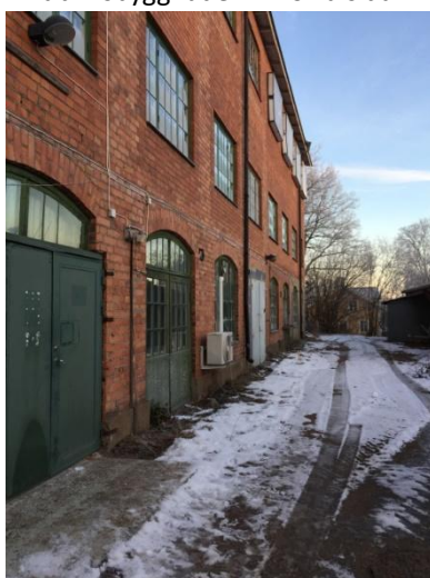
Fabriksbyggnaden – södra sidan
