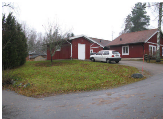
Förrådet som syns på bilden måste tas bort för att ge plats för tillbyggnaden.
