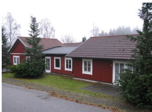
Bilden visar norra sidan av gruppbostad.
