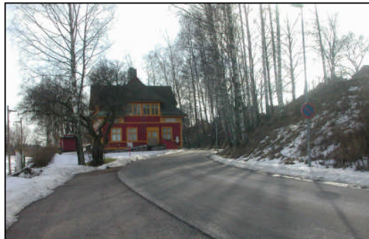
Museispårvägens stationshus och Järnvägsgatan, söder om planområdet
