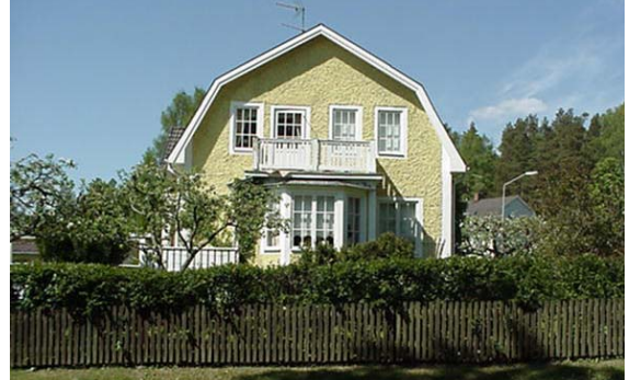
Bostadshus på Klockaren 4, fasad mot Förrådsgatan
