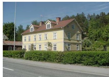
Assessorn 3 fasad mot Landsvägsgatan
