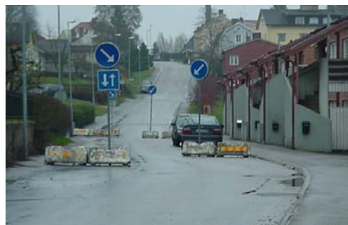
Malmagatan med de provisoriska betongklumparna som är till för att dämpa hastigheten.
