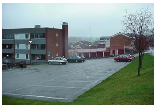
Parkeringsplatsen i norra delen av Beckasinen 2. I bakgrunden syns några av garagen till den senast byggda delen i planområdet.
