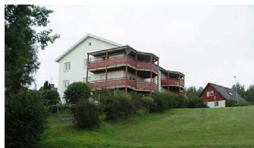
Det färdigrenoverade huset på Rapphönan 16
