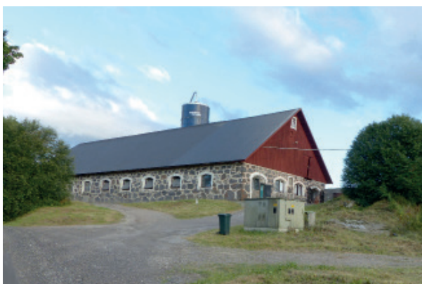
Vid Fräkentorp finns en ladugård från 1800-talet uppförd i natursten med slaggstenar som dekoration.
