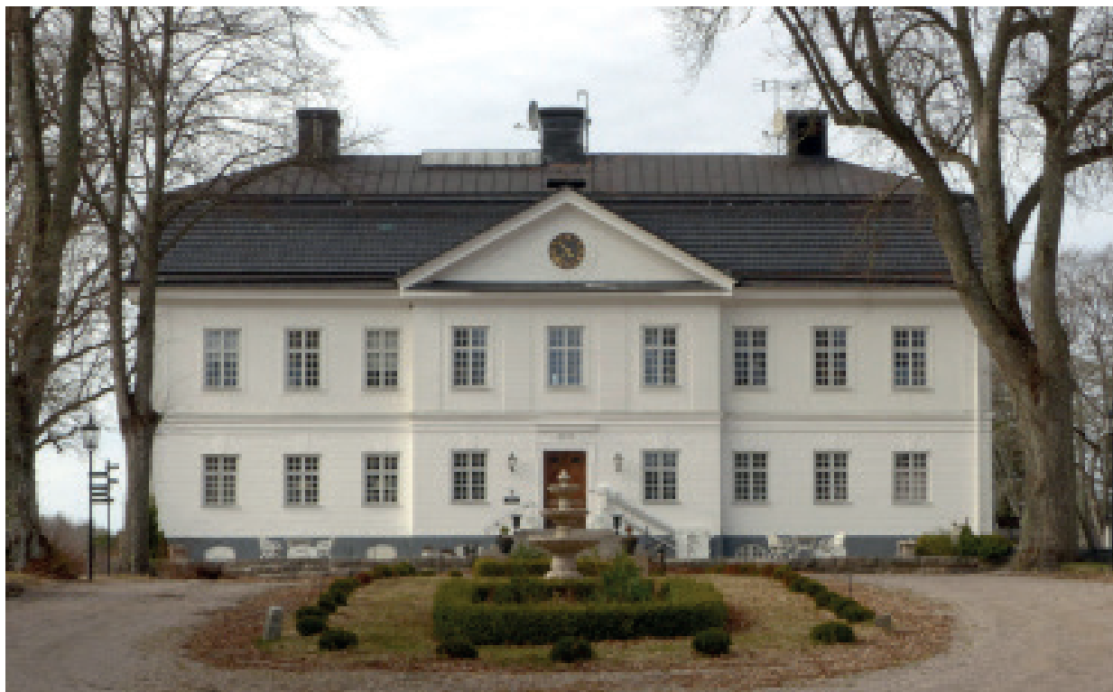
Yxtaholms corps de logi flankeras av två flygelbyggnader och ligger på en udde i Yxtaholmssjön.
