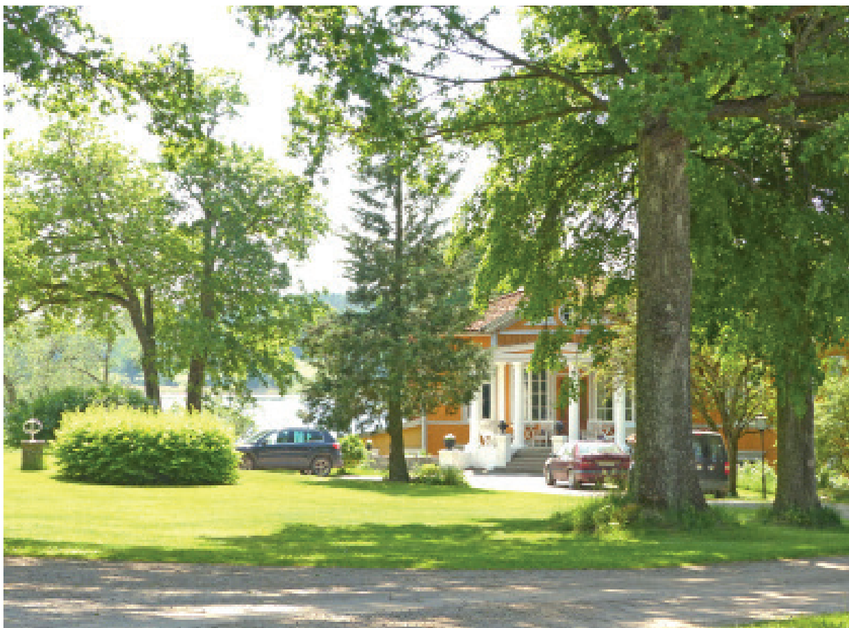
Gryt är en mindre herrgårdsanläggning med huvudbyggnad, troligen från 1700-talet.
