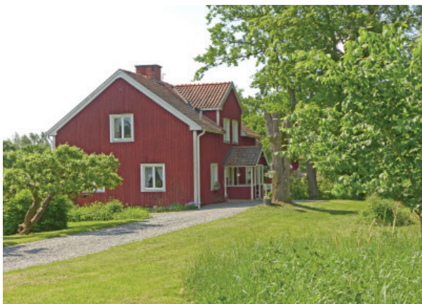
Manhusen i Kulsta har frontespis och är faluröda med vita snickerier.
