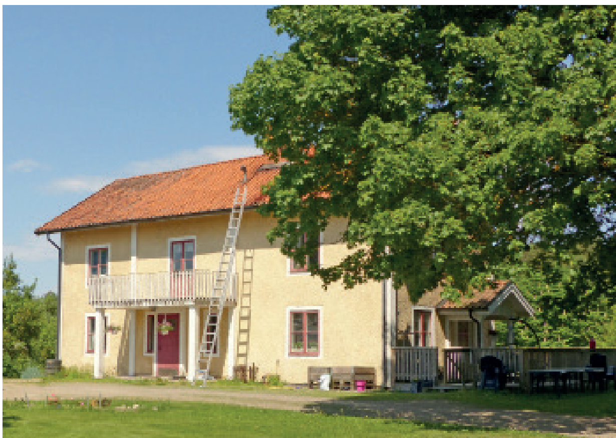
Ett av två ålderdomliga mangårdshus i Fyrby.
