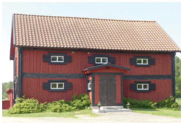
Vid Blacksta gård, nu vingård, märks en äldre magasinsbyggnad.
