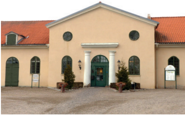
Stallbyggnaden ligger norr om mangårdshuset.
