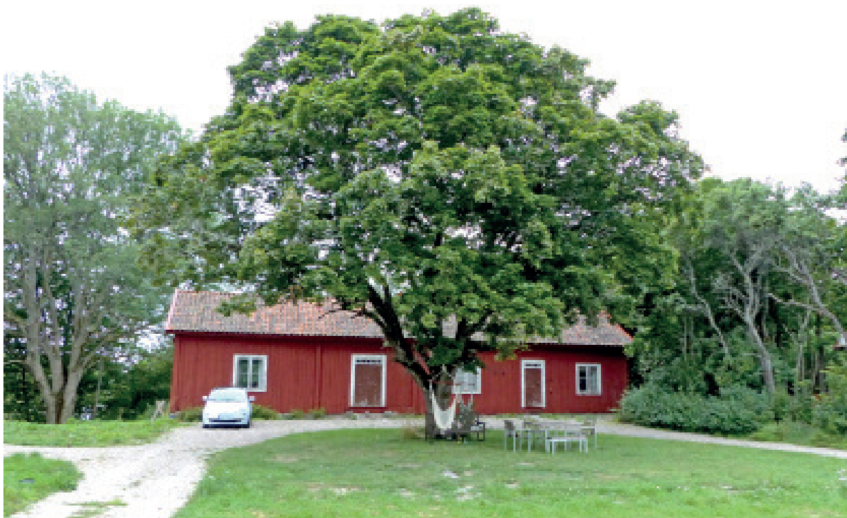
Vid Sund finns en ålderdomlig parstuga från 1700-talet. Till gårdsmiljön hör även yngre bostadshus som speglar olika generationers byggnadstradition.
