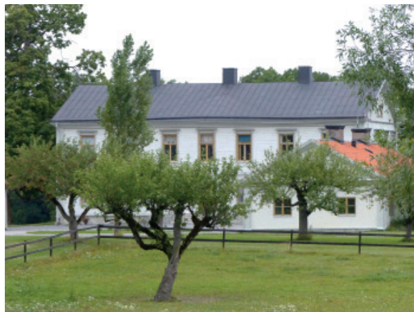
Skedevi uppfördes vid mitten av 1700-talet i timmer och på 1800-talet fick huset en övervåning.
