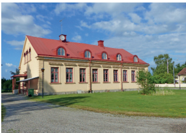
Kyrkskolan ligger på andra sidan landsvägen och är uppförd i nygotisk stil år 1895.
