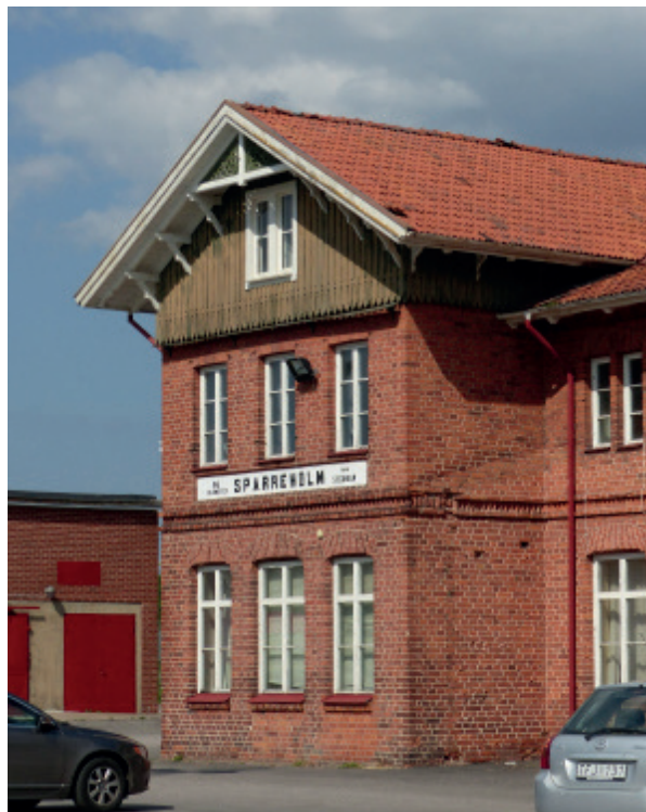
Sparreholms station finns fortfarande kvar invid spåren.
