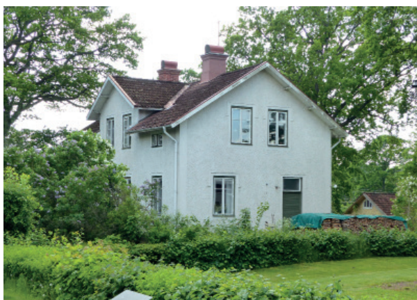
Tidig 1900-talsvilla i Sparreholm med frontespis och putsad fasad.
