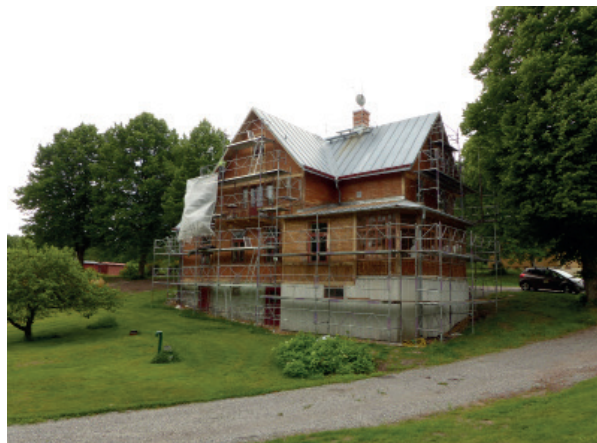
Stationsbyggnaden och andra bostadshus renoveras.
