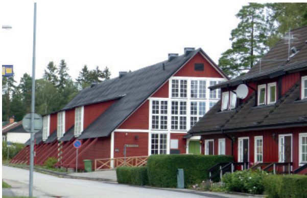
Lägerbaracker har byggts om till vårdcentral och gymnastikhuset på bilden har inspirerat utformningen av en intilliggande radhuslänga.
