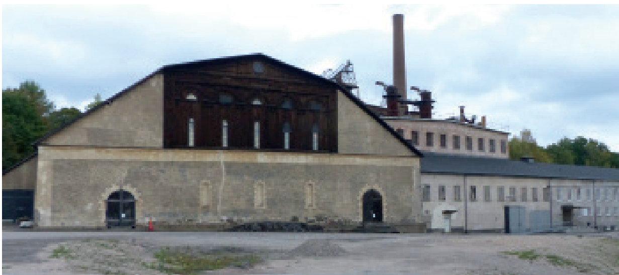
Kolhuset är en av få kvarvarande byggnader från järnbruksepoken. Byggnaden används för teater och musikföreställningar.
