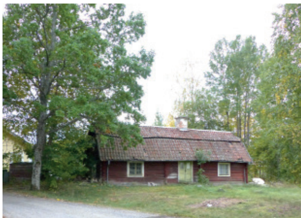
Inte långt från herrgården ligger "Stugan", ett av Hälleforsnäs äldsta bostadshus. Byggnaden är i akut behov av renovering.
