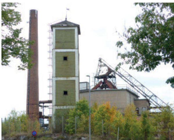
Vid kolhuset finns det kvar en skorsten och ett brandtorn.
