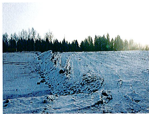
Tjärtippen håller på att täckas med ett 1,7 meter tjockt jordlager. December 2005.
