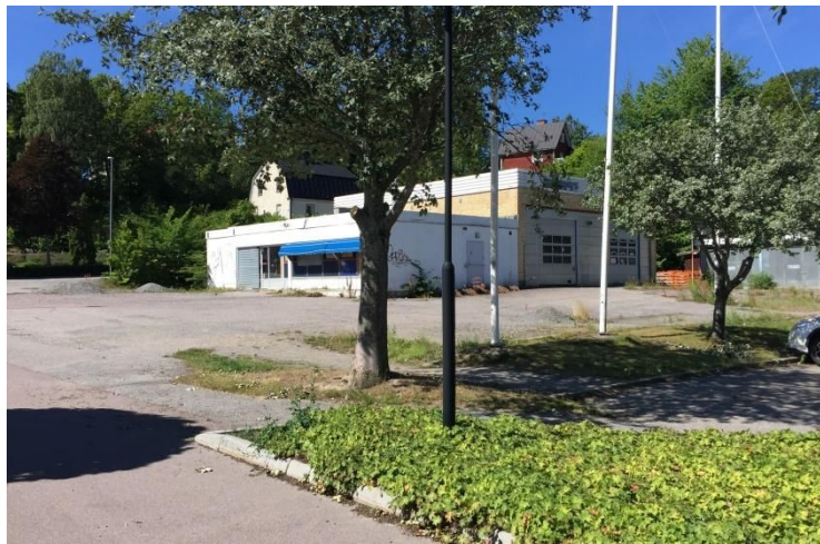
Byggnaden inom fastigheten Parken 4
