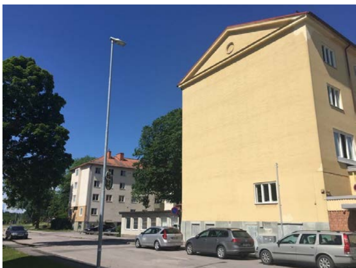
Stadshusgatan sedd västerut med kvarteret Bägaren till höger i bild.
