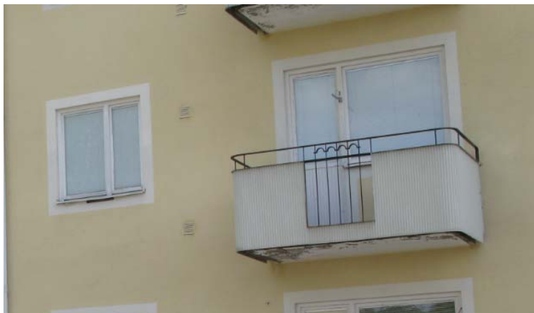
Fönstren på långsidorna har asymmetrisk indelning, på gavlarna har fönstren andra proportioner. Gjutjärnsräckena på balkongerna är en karaktäristisk detalj.
