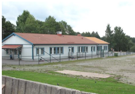
Bilden visar förskolan sedd från östra sidan. En ny byggnad kan lämpligen uppföras på grusplanen intill den befintliga byggnaden.
