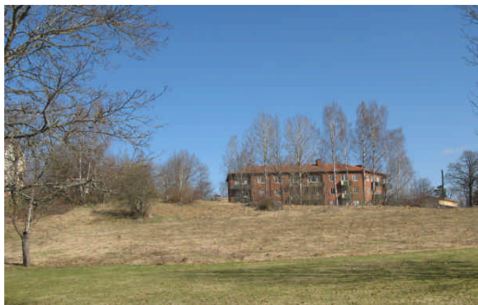
Gruppbofasten avses att placeras där backen börjar. I bakgrunden syns flerbostadshuset på fastigheten Vårloken 7.
