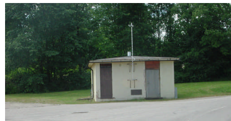
Den gamla pumpstationen vid Variagatan tas bort och ersätts av en ny som placeras längre ner utmed gatan intill gränsen till Volvos fastighet.
