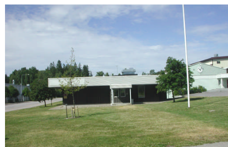
Bilden visar den nyare delen av byggnaderna på Facklan 7. Till vänster syns Drottninggatan.
