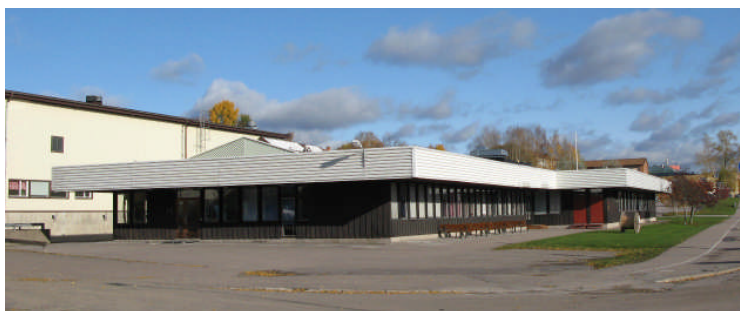
2. Facklan 7. Byggnad mot Drottninggatan
