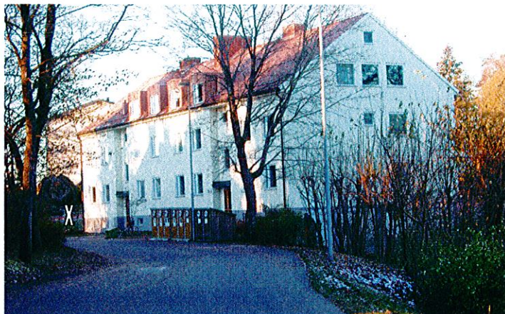
Flerbostadshuset på Geväret 6.
