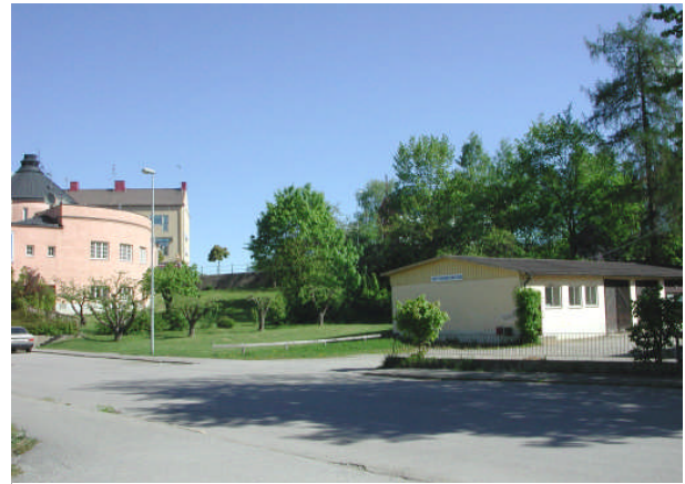
Fastigheten Degeln 4 sedd från Kungsbrogatan. Snickerifabriken kommer att rivas när det blir aktuellt att bygga flerbostadshus.
