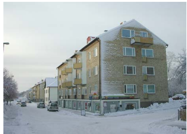
Flerbostadshus som ska byggas om är beläget på fastigheten Disponenten 2.
